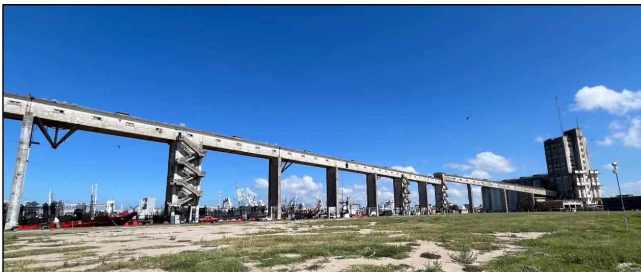
Galería de Embarque Granelera - manga, torres y tabiques
