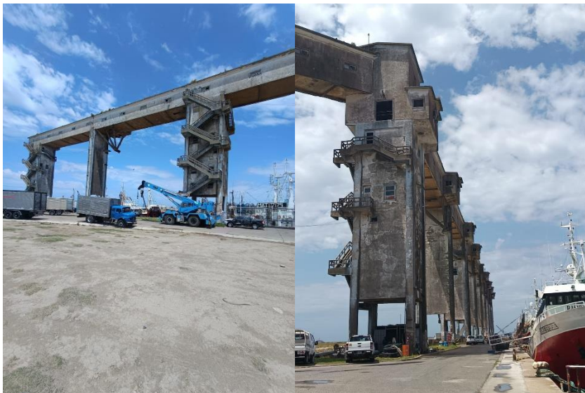
Foto 7: Vista de la galería, torres, escaleras y tabiques
